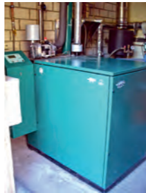
Blockheizkraftwerk
